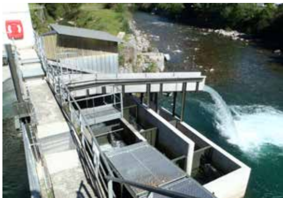
Passé à poissons et dévalaison Licq (@ SHEM)
